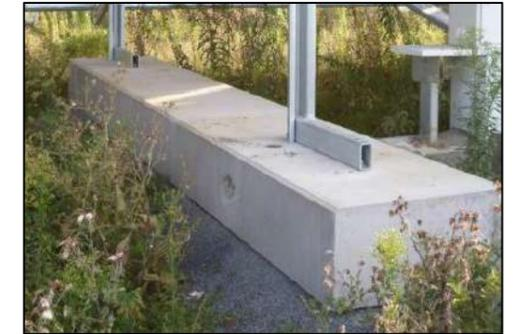
Figure 16 : Types de fondation - semelle béton
